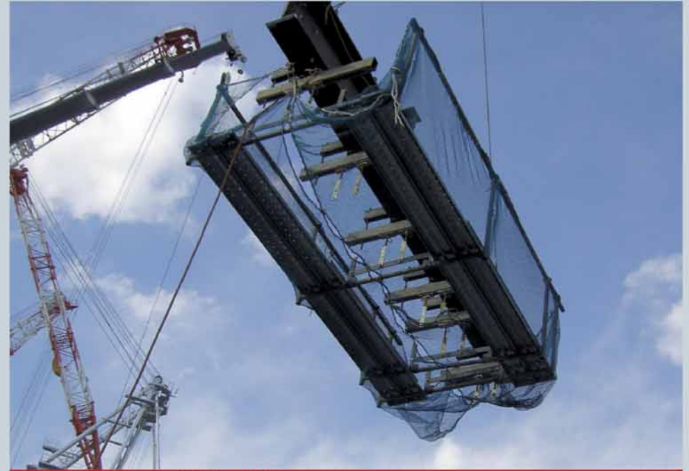
SRC構造梁の一連作業に対応
